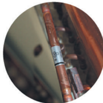
Обратный клапан в нижней части чиллера
